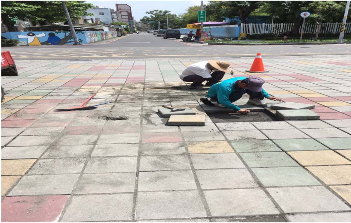
入口車道磚整平鋪設中
