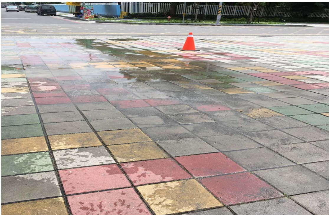
入口車道磚鋪設完成
