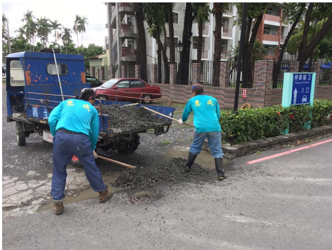
停車場入口鋪設級配
