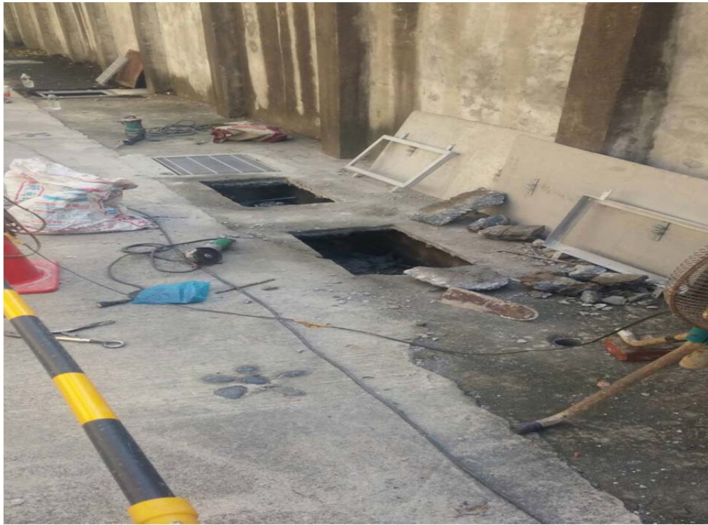
蕙蘭樓後方水溝清淤整理
